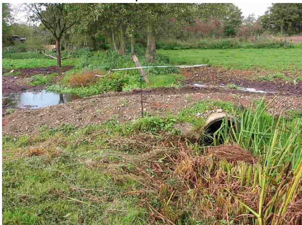
Abbildung 16: Sanierte Furt in Nieperfitz
