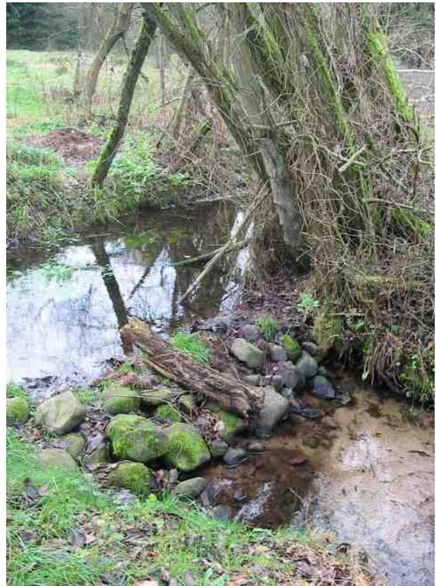
Abbildung 17: Neue Sohlgleite (bei Niedrigwasserstand)
